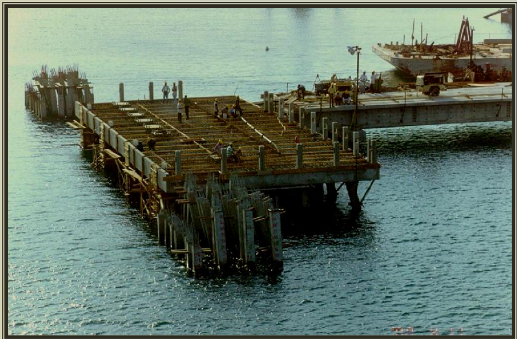
Montaje de Elementos prefabricados Plataforma de Operaciones Abajo: Vista general de la Plataforma en proceso de montaje
