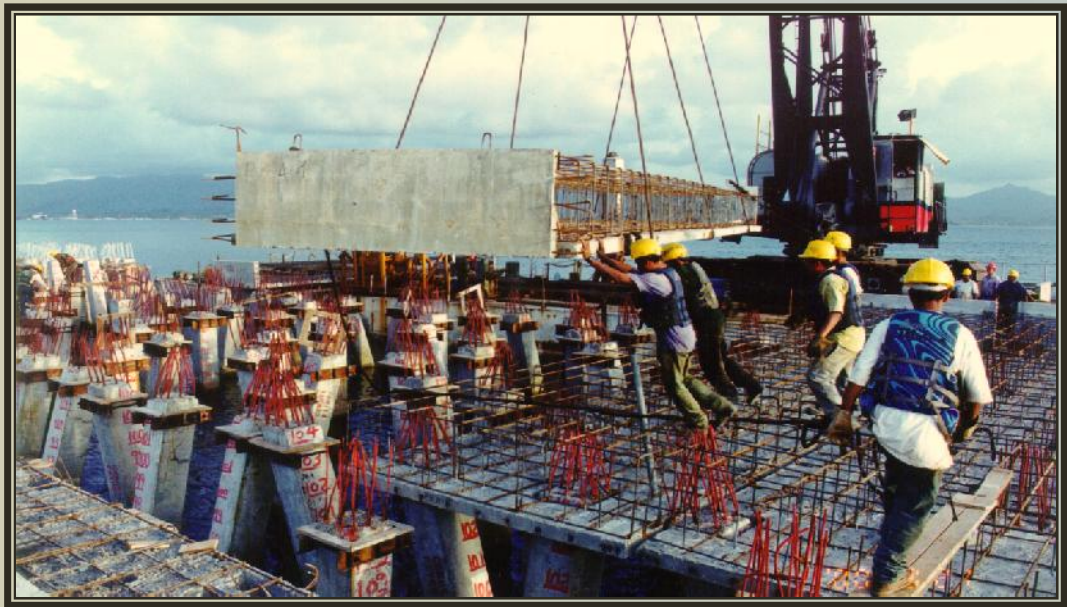
Montaje de Elementos prefabricados Plataforma de Operaciones Abajo: Vista general de la Plataforma en proceso de montaje
