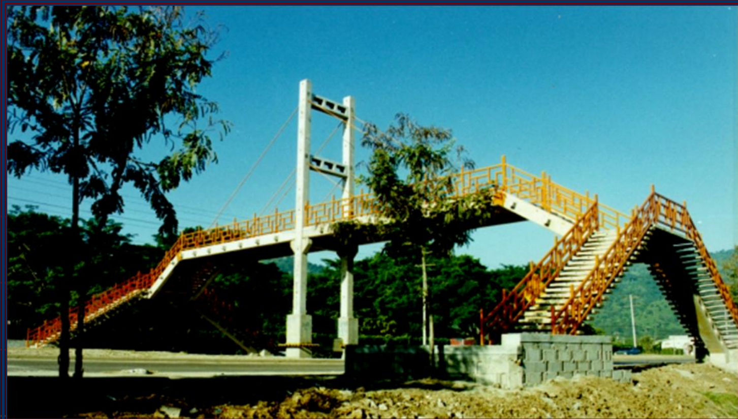
● Puente Peatonal – Zip Búfalo S.P.S. L-30.00 mts
