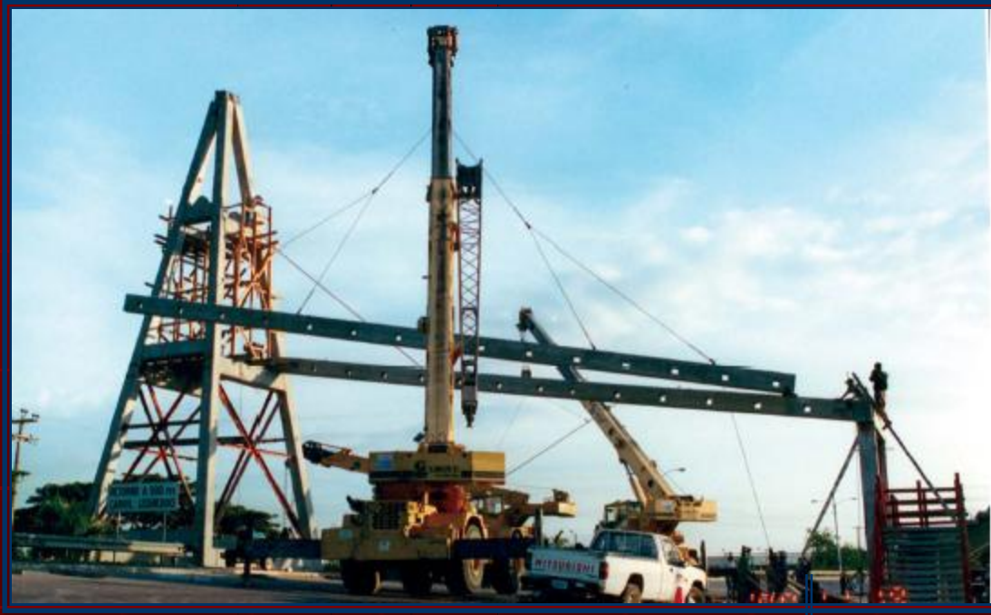
● Montaje de Vigas Principales
