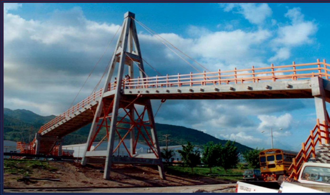
● Vista Lateral Izquierda Puente Peatonal, Zip Buena Vista
