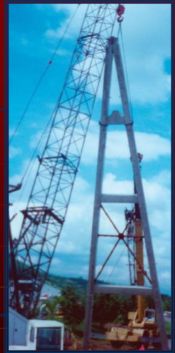
● Montaje de Torre Principal
